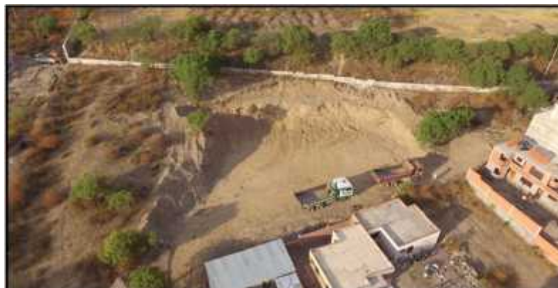
Tramo 3 tanque Tiupaya.
