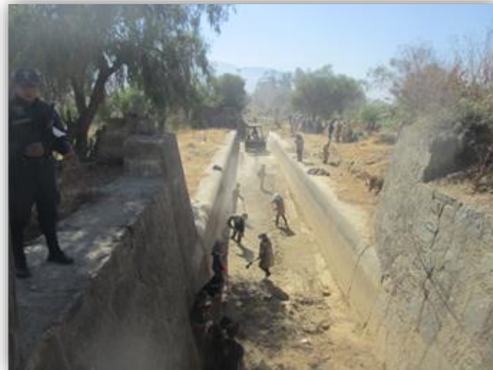
Mantenimiento de torrenteras y encauces
