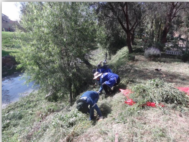
Limpieza del Río Maylanco (D-3)
