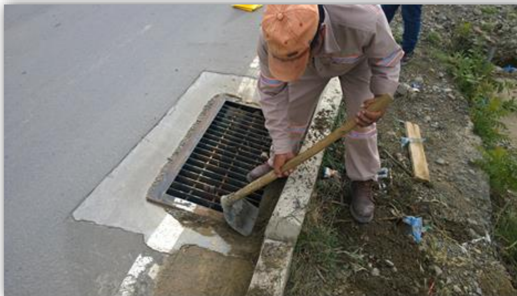
Limpieza de canales
