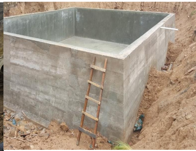
Construcción Sistema Micro riego Laraty
