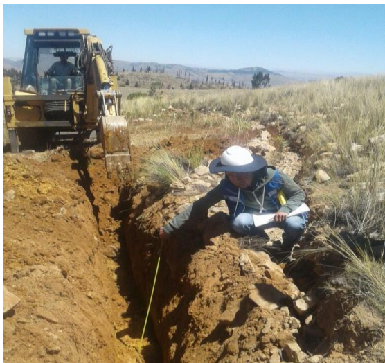
Construcción Sistema Micro riego por aspersión Koluyo
