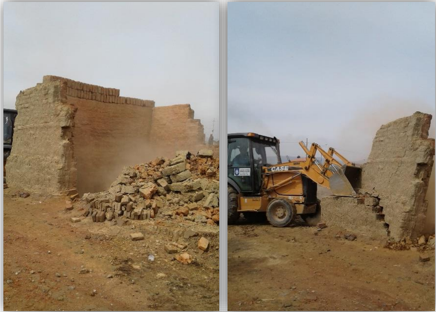
Demolición de ladrilleras – Zona Oroncota (El Abra)
