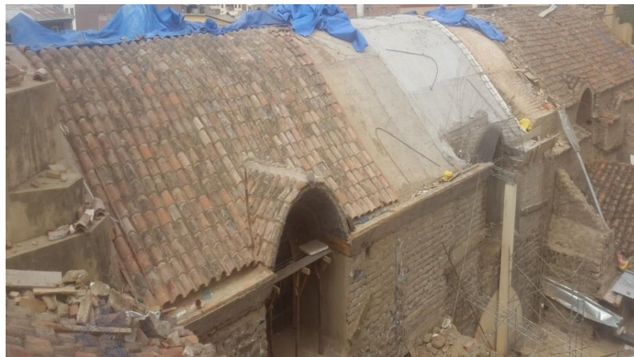
Restauración Patrimonio Cultural Iglesia San Pedro de Sacaba
