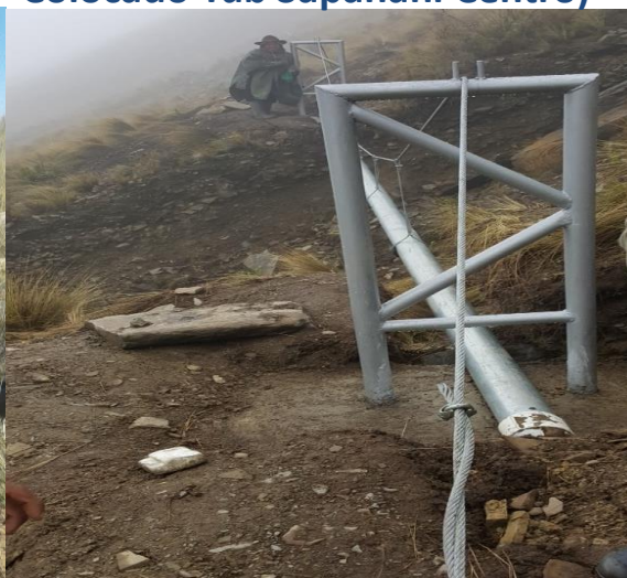
Construcción Sistema Micro riego Subcentral Sapanani (Tend. Colocado Tub Sapanani Centro)
