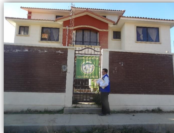
Inspecciones a AOPs
