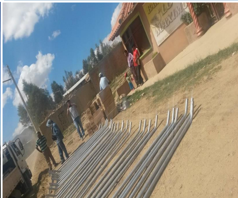
Reposición postes brazos y luminarias
