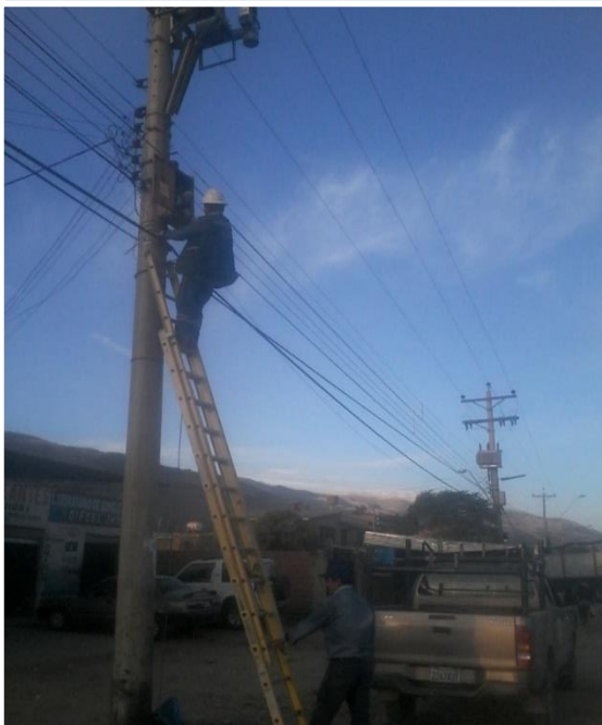
Mantenimiento de alumbrado público
