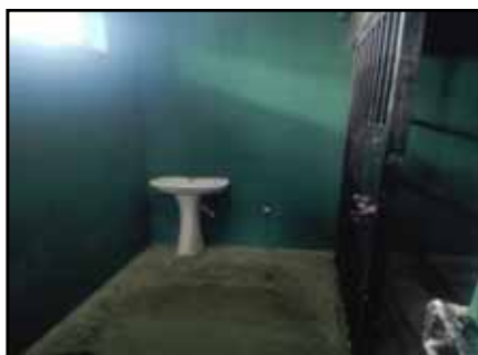
MTTO Y MEJORAMIENTO ESTACION POLICIAL 1 « LAVA MANOS » (EPI-1)
