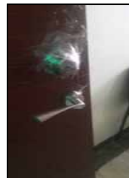
MTTO Y MEJORAMIENTO ESTACION POLICIAL «PUERTA» D-1(EPI-1)
