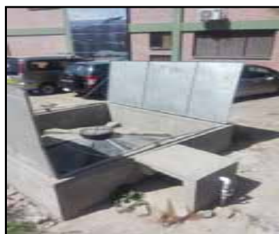
MTTO Y MEJORAMIENTO «TANQUE DE AGUA» 1 (EPI-1)
