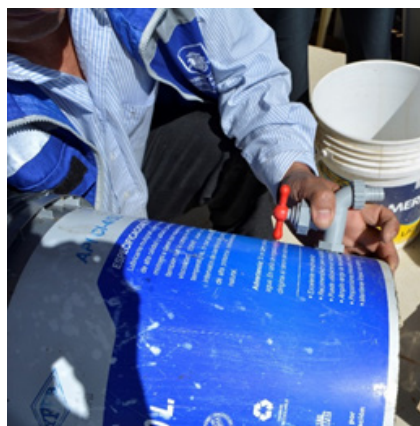
Foto 5. Instalación de grifo de 1/2"
