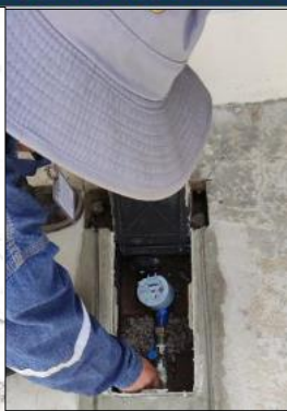
Instalación de Medidores de Agua Potable.
