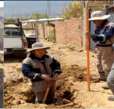
Detección de conexiones clandestinas.
