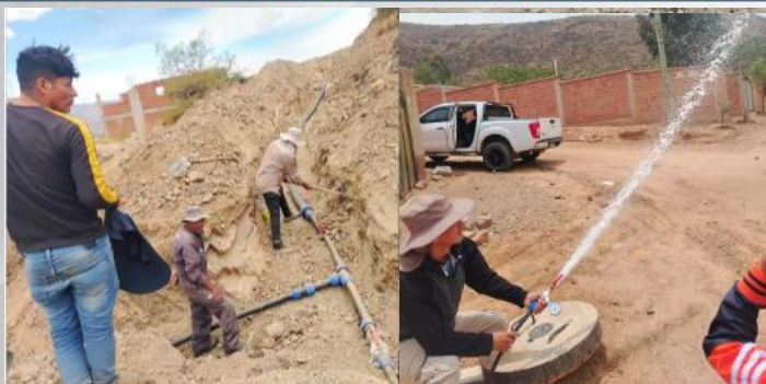
Construcción red de agua potable, Polígono D-6
