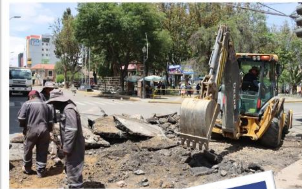
Trabajos en la plaza
