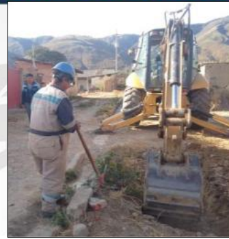
Detección de conexiones clandestinas.
