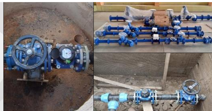
FOTO 4: Macro medidores instalados
