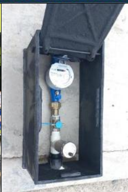
Instalación de Medidores de Agua Potable.
